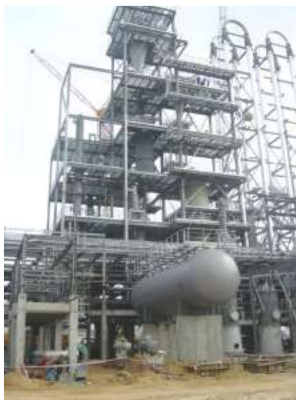
Budowa stropów roboczych w Petrochemii Płock
