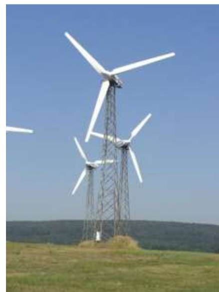
Maszy elektrowni wiatrowych w Słupsku
