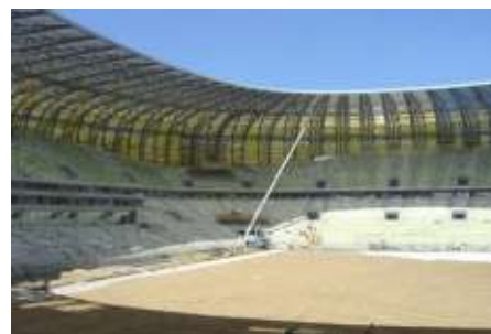
Konstrukcje Gdańskiego Stadionu
